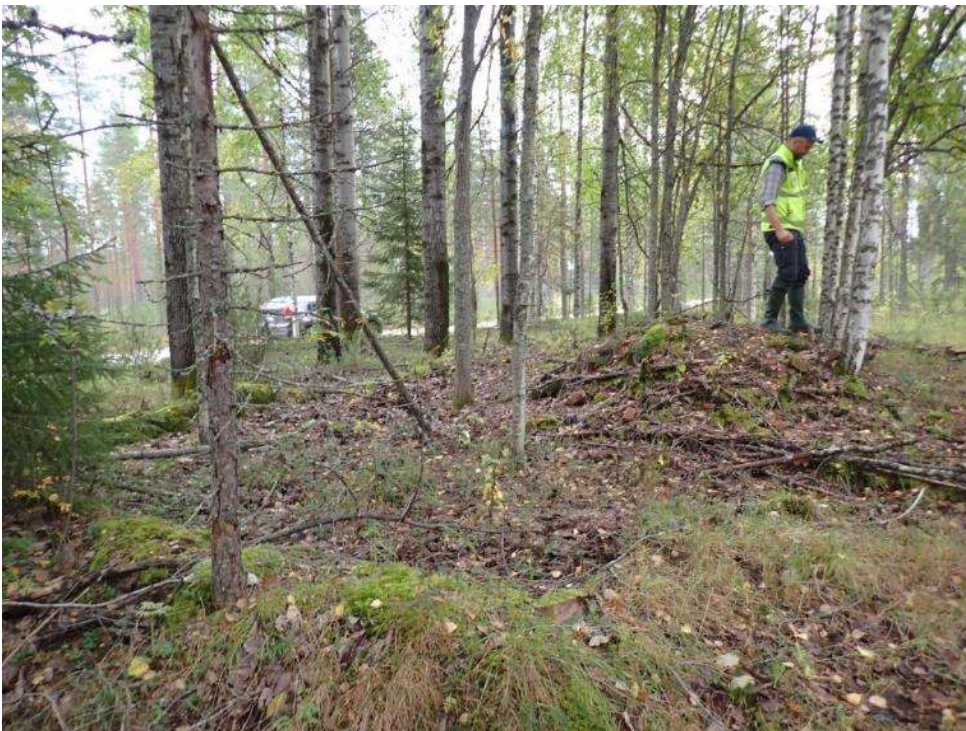
Kuva 48. Teemu Tiainen tarkastamassa rakennuksen perustaa. Lounaaseen.
