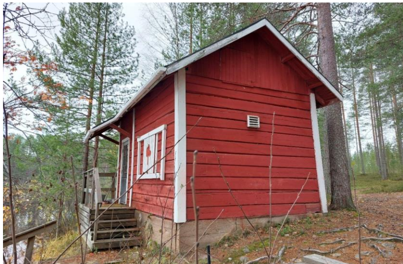
Haaponivan kämppä ja sauna (Metsähallituksen kohdeinventointi, 2024)
