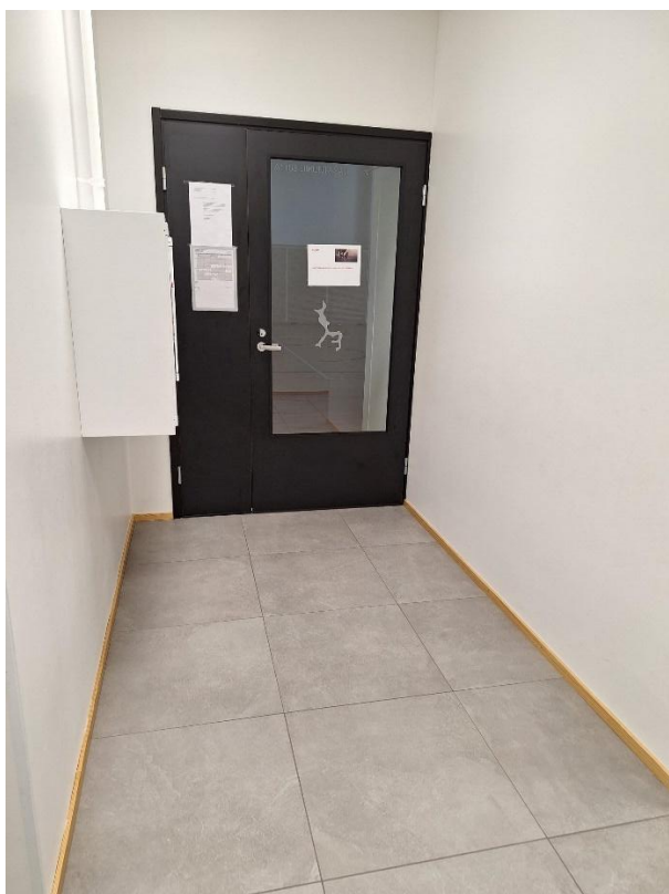
Ovi liikuntasaliin (riittävän leveä ja kynnyksetön).
