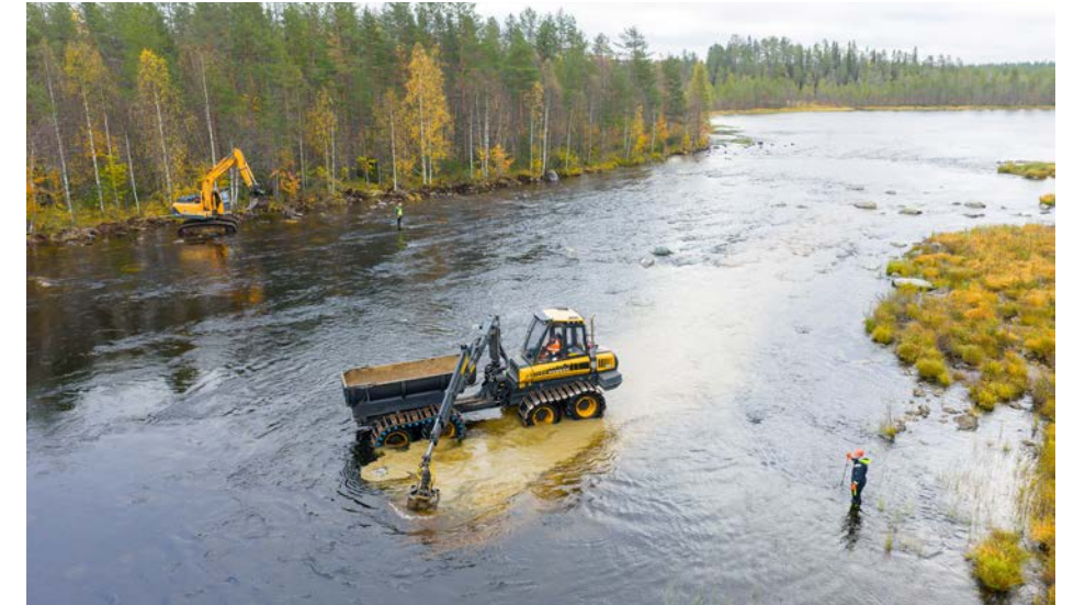
Hossanjokea kunnostetaan kesällä 2025. Kuva: Hannu Huttu.
